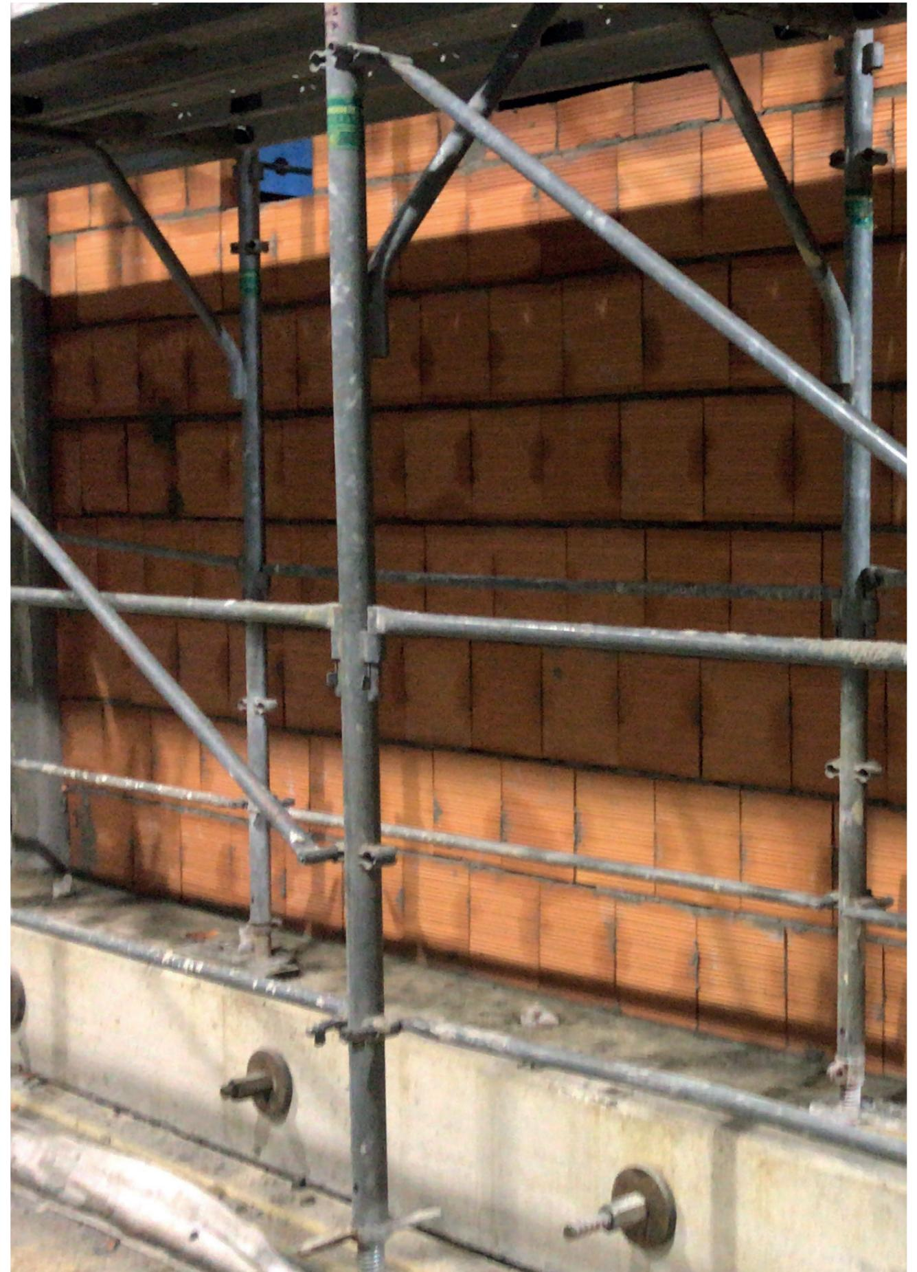
FIGURA 70 - Tamponamento del primo piano degli edifici.
