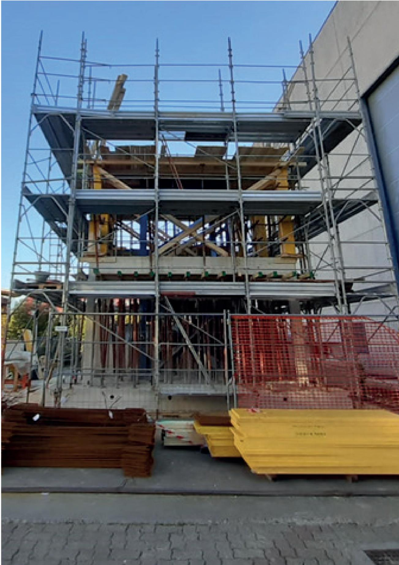
FIGURA 63 - Fase realizzativa del secondo piano degli edifici all'esterno dei laboratori (vista 1).
