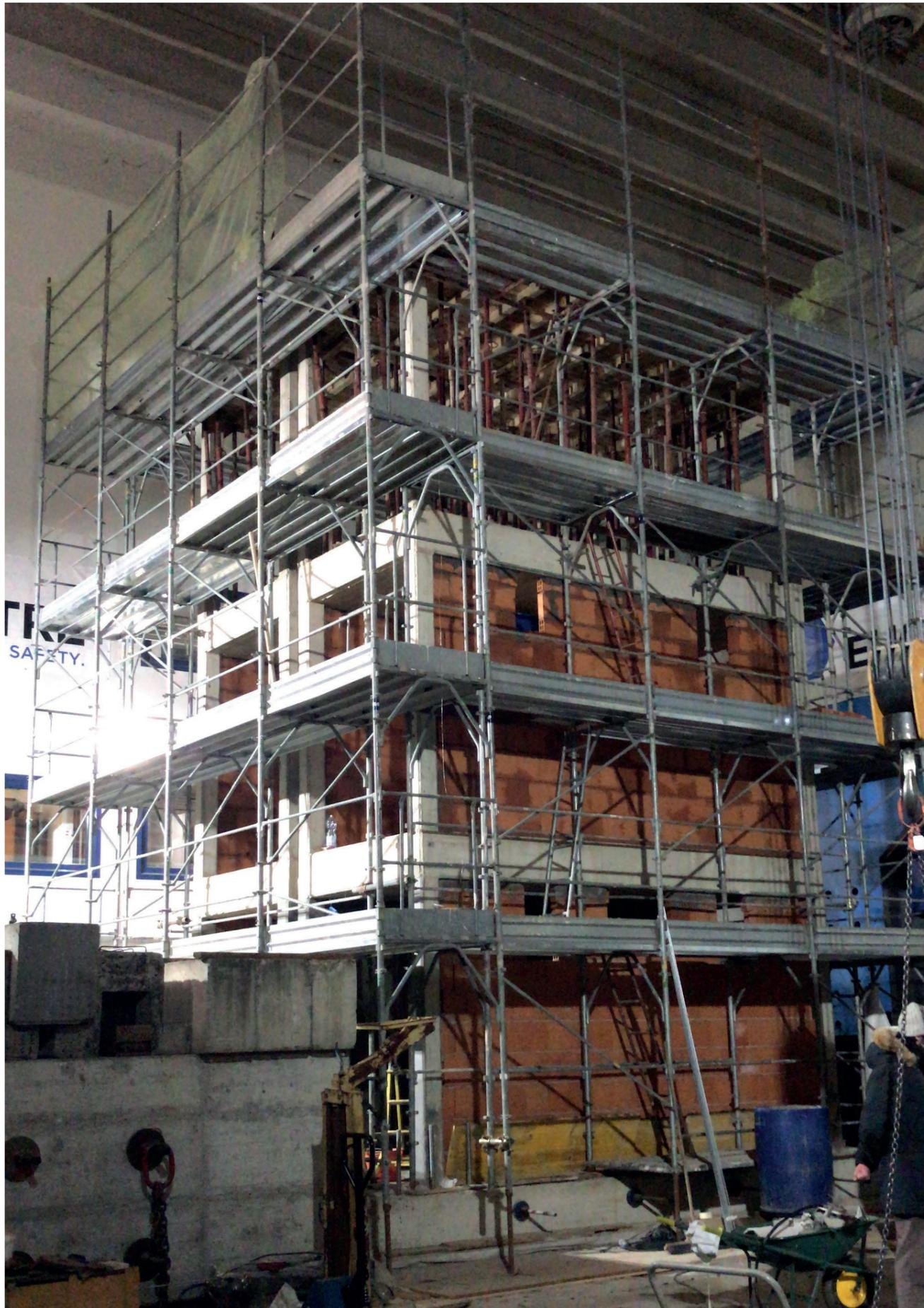
FIGURA 71 - Fase di realizzazione del terzo piano dei telai in c.a. degli edifici e inizio dei tamponamenti in laterizio.
